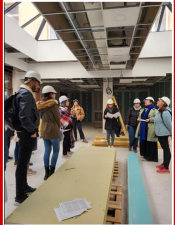
Carrefour des Cultures Africaines, Chantier 2022, @ L. Zerbini
